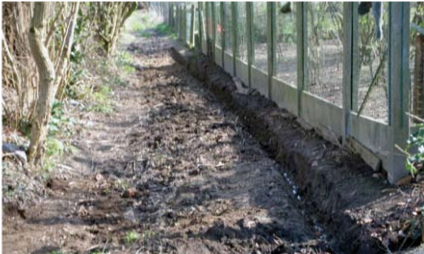
De 'Smelterijweg' in Onkerzele: vrijwilligers van Rebus vzw verplaatsten de moddergracht van het midden naar de kant van de weg
