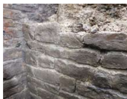
Breukstenen in de muur evenwijdig aan de Molenstraat en regelmatig bouwpatroon in de muur dwars op de richting van de Dender.
