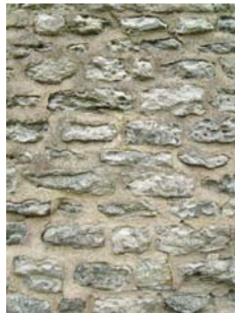
Rechts: detail van de muur van de Dierkost, veldsteen met brede voegen (2008)
