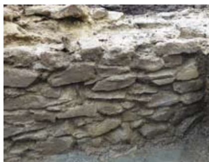
Breukstenen in de muur evenwijdig aan de Molenstraat en regelmatig bouwpatroon in de muur dwars op de richting van de Dender.
