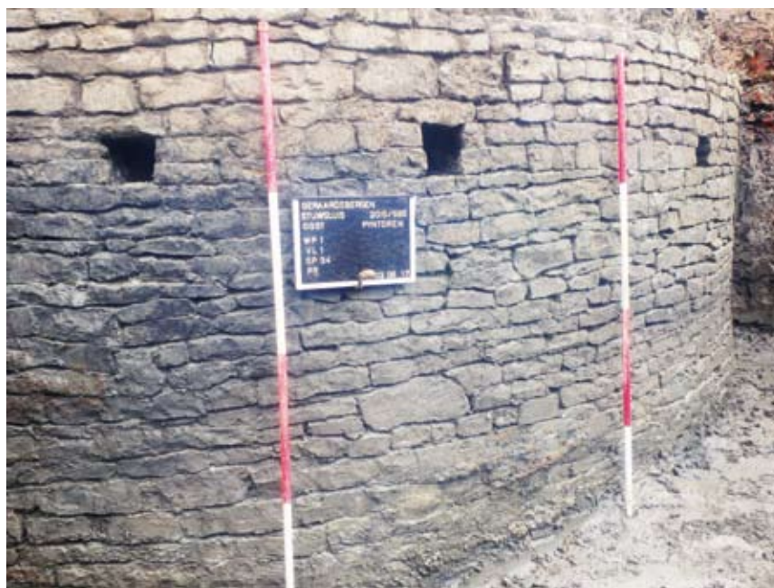
Detailfoto van de uitsparingen voor de vermoedelijke stellingbouw (foto richting noordoosten)
