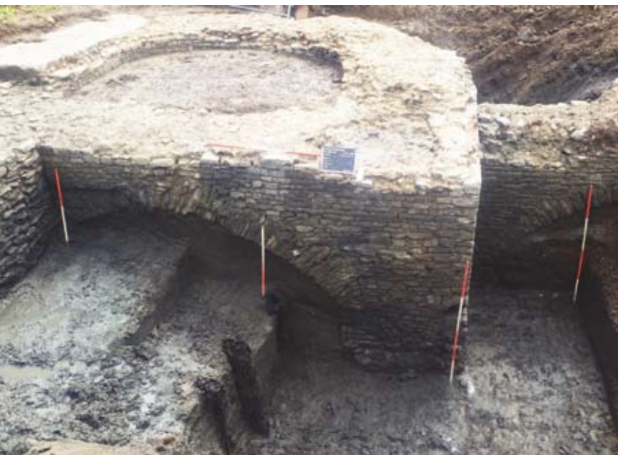
Zicht op de bewaarde fundering van de Pijntoren met zichtbare spaarboog
