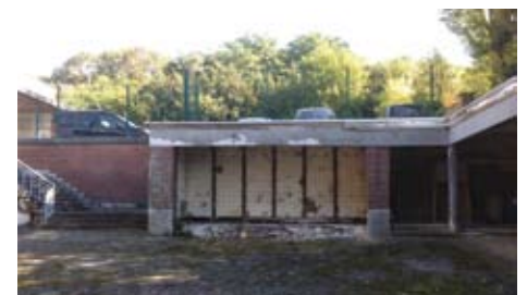
Zicht op de achterwand van het weggebroken sanitair (Foto Dirck Surdiacourt, 2016)
