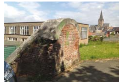
Zicht op toegang D met links de turnzaal en recht een zicht op de Sint-Bartholomeuskerk (Foto Dirck Surdiacourt, 2016)
