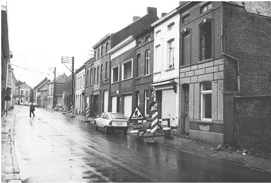
De huizen aan de Oudenaardsepoort kort voor de sloop
