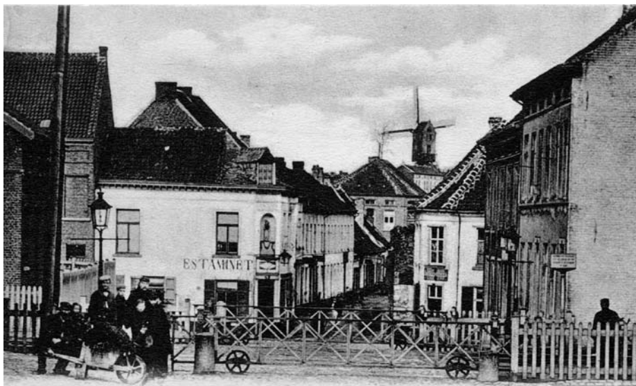
De Oudenaardse Poort gezien vanaf de vroegere overweg voor de gedeeltelijke afbraak met op de achtergrond de Vera Pazmolen.
