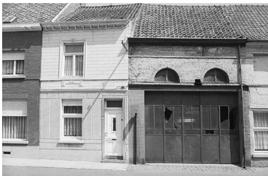
Gezicht op het werkhuis van Willems en het ouderlijk huis van R. Van Damme, enkele jaren voor de sloop
