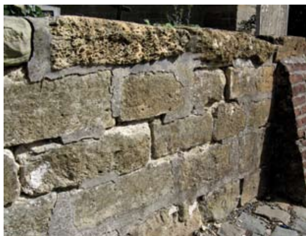
Ook de kerkhofmuur van de Sint-Jan-kerk werd hoofdzakelijk met nummulietenkalkzandsteen opgetrokken. Bij restauratie van kerk en muur werden helaas zandstenen van vreemde origine gebruikt (Foto E. Cosyns, 2015)
