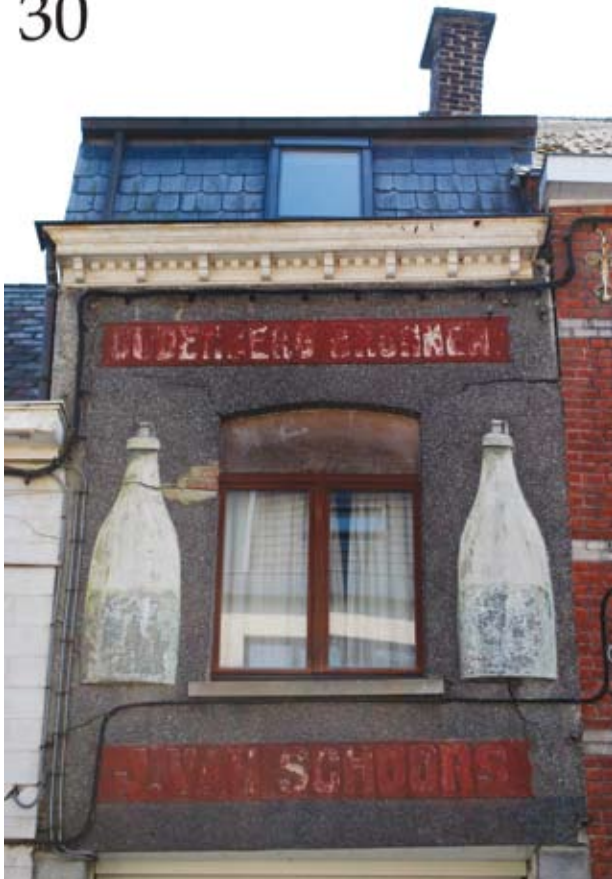
Een opmerkelijke gevel met publiciteit voor het Geraardsbergs mineraal water Oudenberg Bronnen (Foto J. De Ro)
