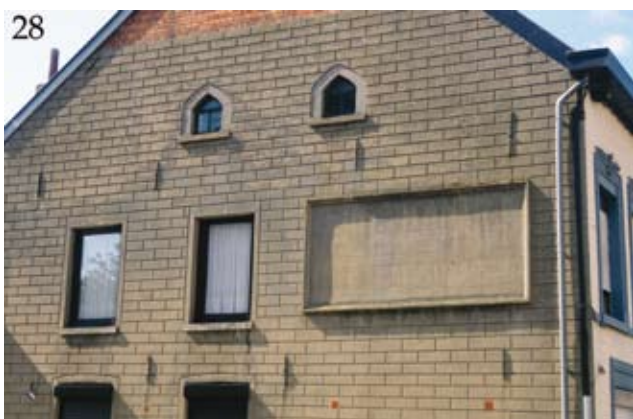
Op deze gevel in de Gentsestraat is eertijds binnen een gecementeerd kader geschilderde tekstreclame aangebracht (Foto Ph. Haegeman)
