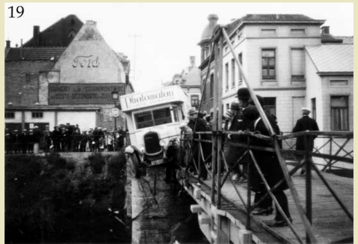
De blinde zijgevels op de hoek van de Begijnhofkaai wisselen regelmatig van geschilderde gevelreclame (ongedateerd)
