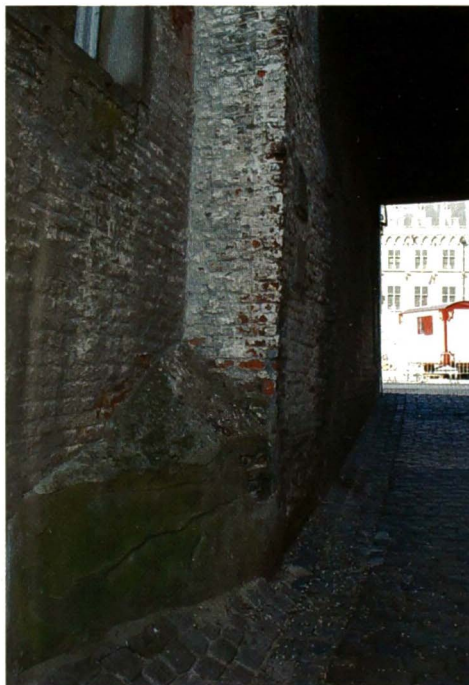
Bij de overwelling van het Duivenstraatje. (augustus 2013) (Foto J. De Ro)
