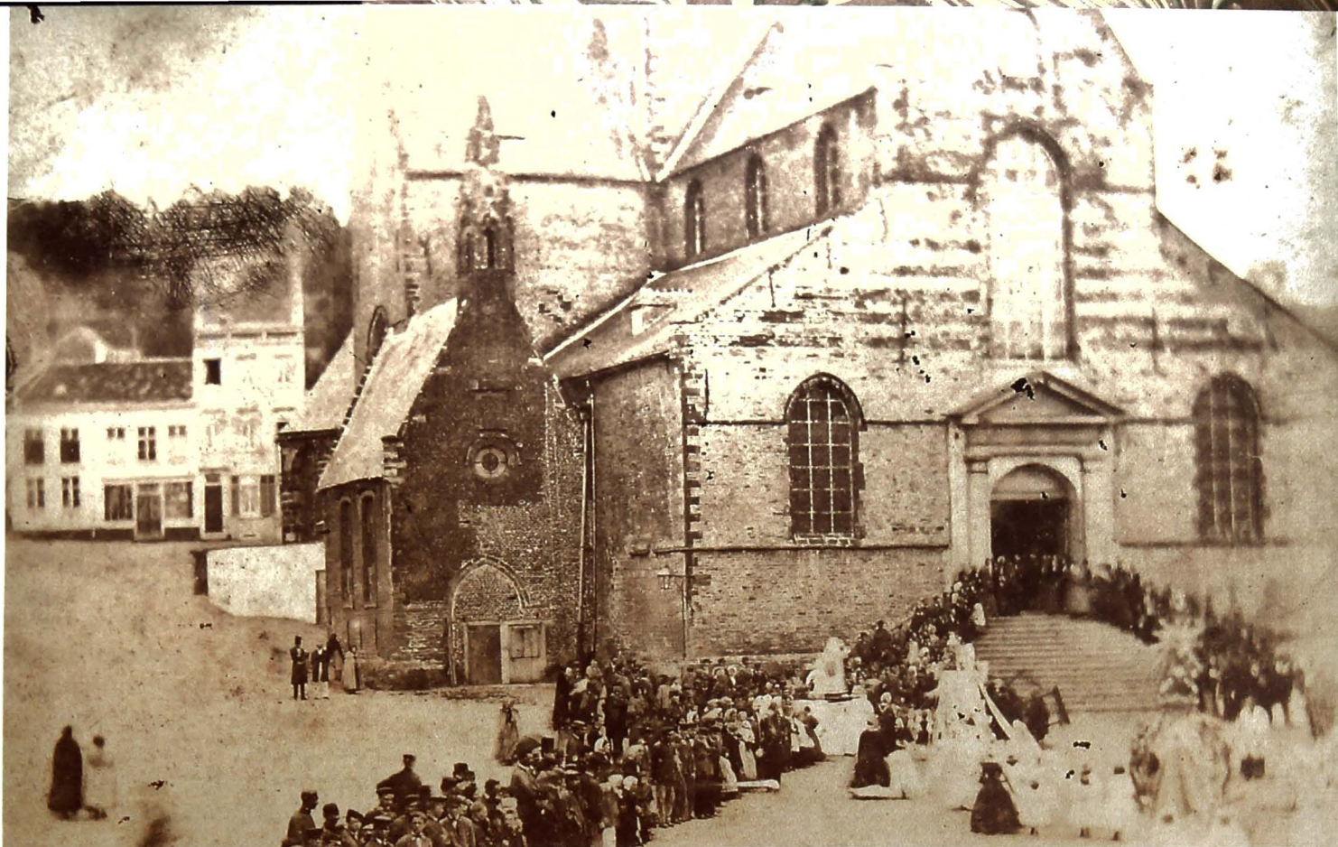
Beeldopname van de Sint-Joriskapel uit 1876. Na de afschaffing van de gilde in 1793, raakt het gebouw bij gebrek aan onderhoud in sterk verval. De spitsboogvormige toegangspoort is dichtgemetseld en vervangen door een gewone deur en dito venster. In 1870 wordt de kapel verenigd met de hoofdkerk. De restauratie komt er pas in de loop van de jaren 1890. (Privéverzameling André Van Der Kelen)
