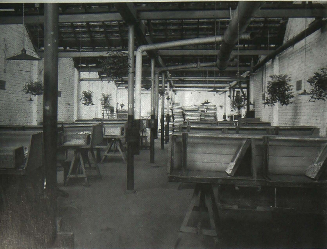
Een binnenzicht op de voormalige 'De Launoit'-fabriek, waar Maurice Van Buggenhoudt directeur was vanaf 1931.
