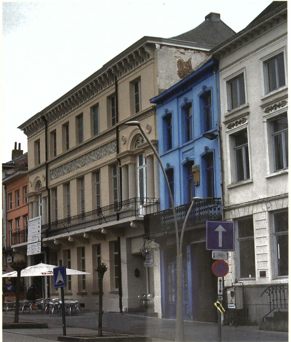
De Liberale Kring met de gerestaureerde voorgevel (mei 2012). (Foto Jacques De Ro)
