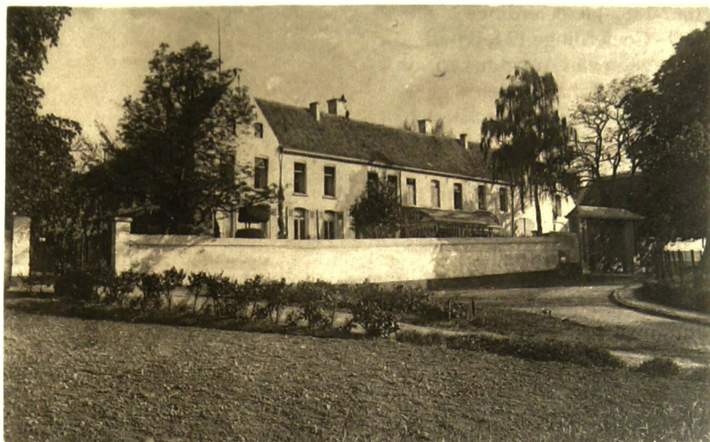
Het hof Ter Elzen in de Kerkstraat - 1935
