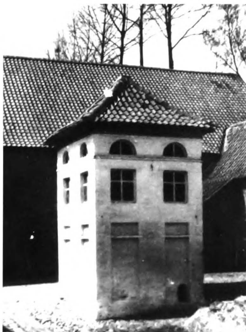
Duiventoren in de Moenebroek (2009). De heerlijkheid Moenebrouck was een vol leen van het leenhof van Marke en Ronne, en dus sedert het einde van de dertiende eeuw een achterleen van het leenhof van Heinsberg in Duitsland en later van het leenhof van Gullik. De vierkante witgekalkte duiventoren op de binnenkoer van de hoeve Ruisenbroekstraat 4 herinnert mogelijk aan het heerlijk recht van het houden van duiven. In de negentiende en twintigste eeuw is de boerderij eigendom van de familie Van Heghe.
