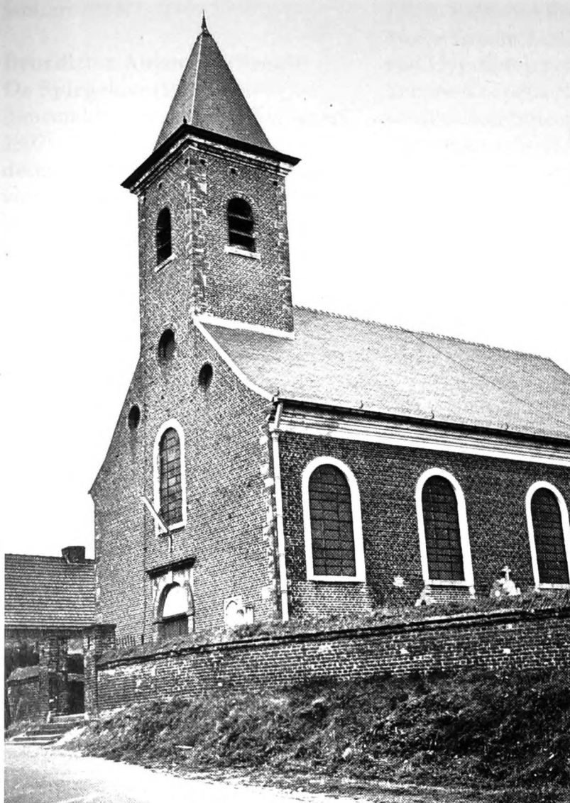
Sint-Amanduskerk Smeerebbe - 1911. Het zaalkerkje met westtoren en schip dateert uit 1792-1794. Het klein gotisch koor en de sacristie zijn een paar eeuwen ouder. De kerk is omringd door een kerkhof met een bakstenen muur. In de kerk bevindt zich een merkwaardige, veertiende-eeuwse hardstenen doopvont.
