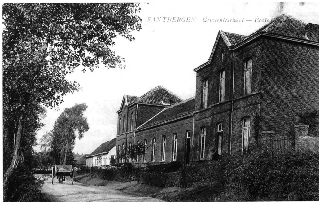
Gemeenteschool – 1906. In de Peperstraat wordt rond 1860 de gemeenteschool gebouwd. We bemerken hier het oorspronkelijke langwerpige gebouw met een lage middenvleugel en twee symmetrische hogere blokken. In het linkerblok is het gemeentehuis ondergebracht en in de rechterblok het schoolhuis (geboortehuis van kunstschilder Jan De Cooman). (Verzameling Ph. Haegeman)
