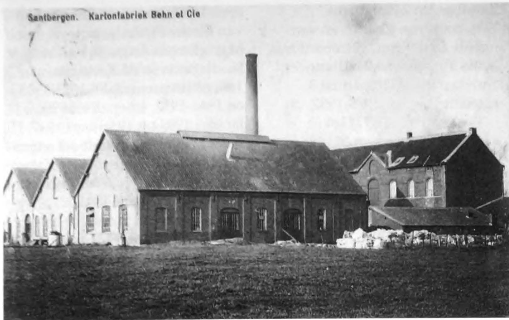
Kartonfabriek – 1913. In 1897 bouwt Behn & Cie nabij het station een kartonfabriek. Vooral tussen beide wereldoorlogen kent de fabriek een grote bloei. In de jaren vijftig begint het verval. Na een aantal jaren leegstand worden in 1978 de gebouwen gesloopt. De afbeelding toont een deel van de bedrijfsgebouwen en de fabriekschouw. (Verzameling J. Mathijs)
