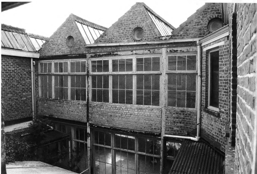
Achter het herenhuis staat de oude klakkenfabriek van de gebroeders Verschaffel nog rechtop (Foto J. De Ro)
