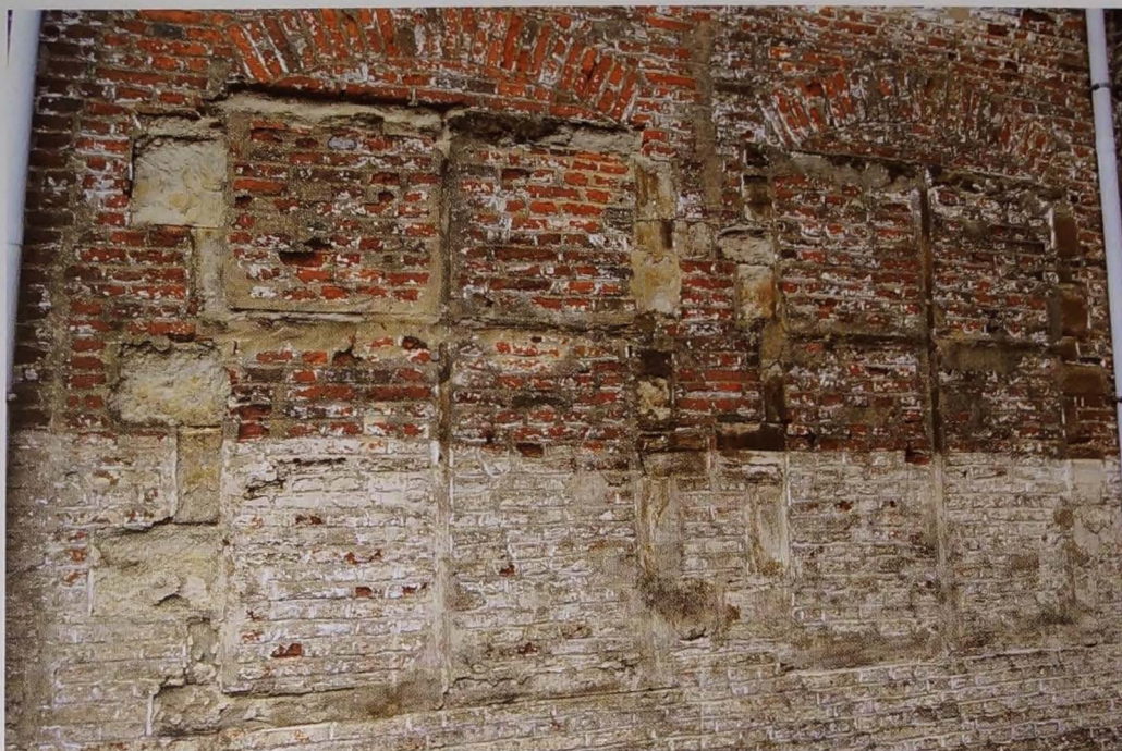
De twee grote zandstenen kruisvensters in deze blinde zijmuur wijzen op een oude kern (Foto J. De Ro)
