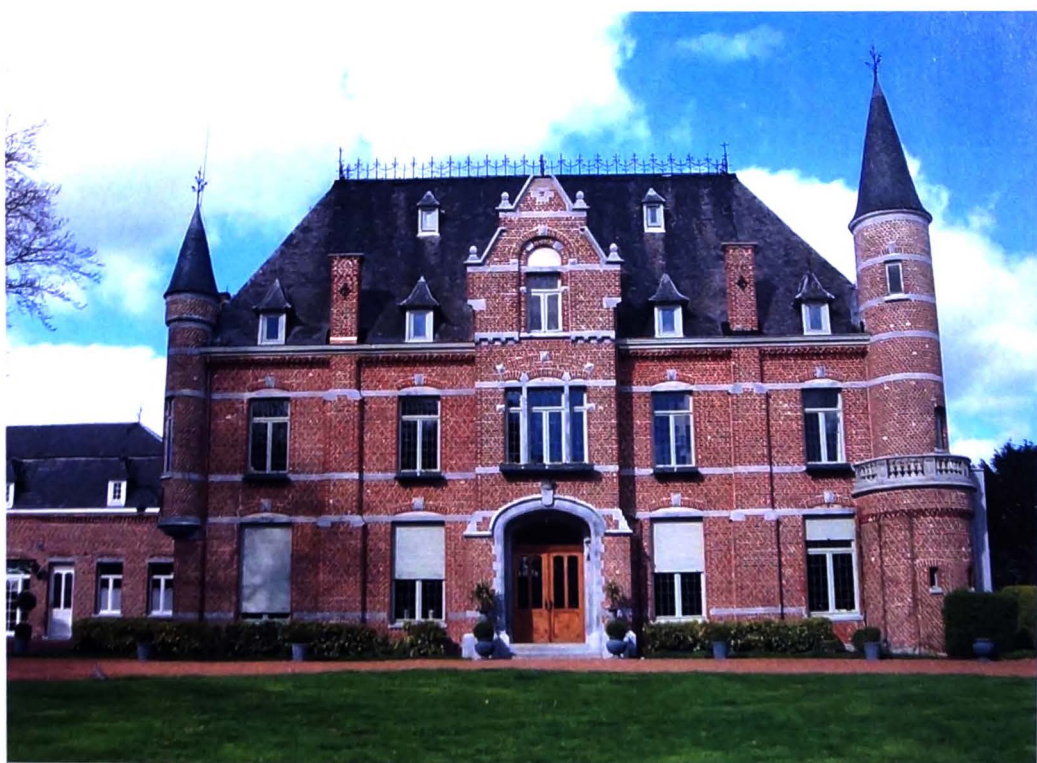
Het 'Oudenbergkasteel' is in 2007 opnieuw in haar oude glorie hersteld. De gevels zijn ontdaan van klimplanten, gereinigd en opnieuw gevoegd. (Foto J. De Ro)
