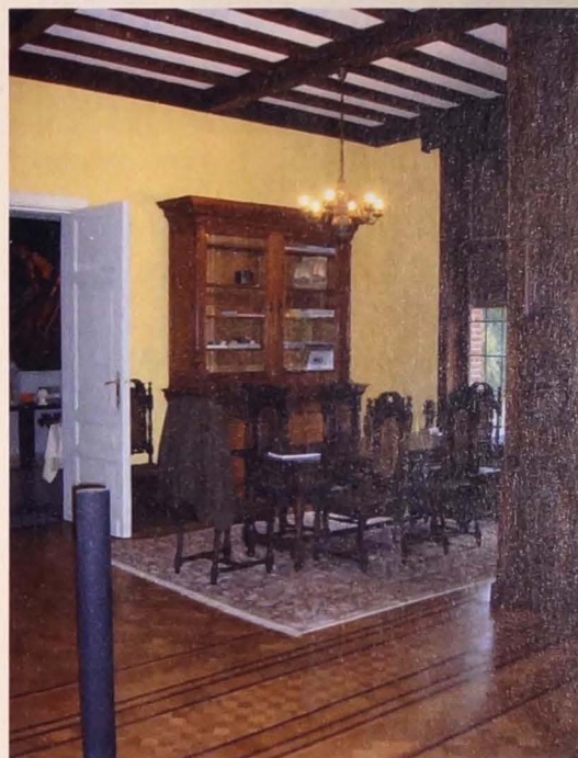
Een van de salons in fel geel heeft een plafond met kinderbalken, die later zijn aangebracht. (Foto J. De Ro)
