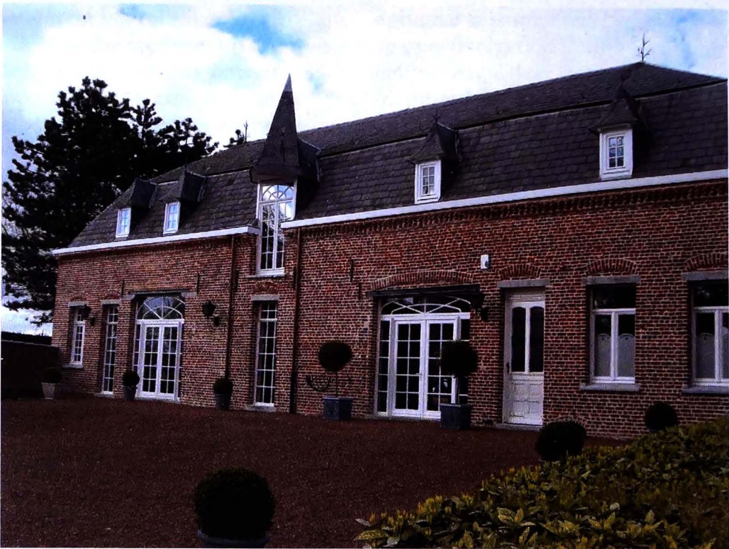
Het vernieuwde buitenschrijnwerk met kleine glasraampjes in de gerestaureerde stalvleugel zorgt voor meer licht in het gebouw. (Foto J. De Ro)
