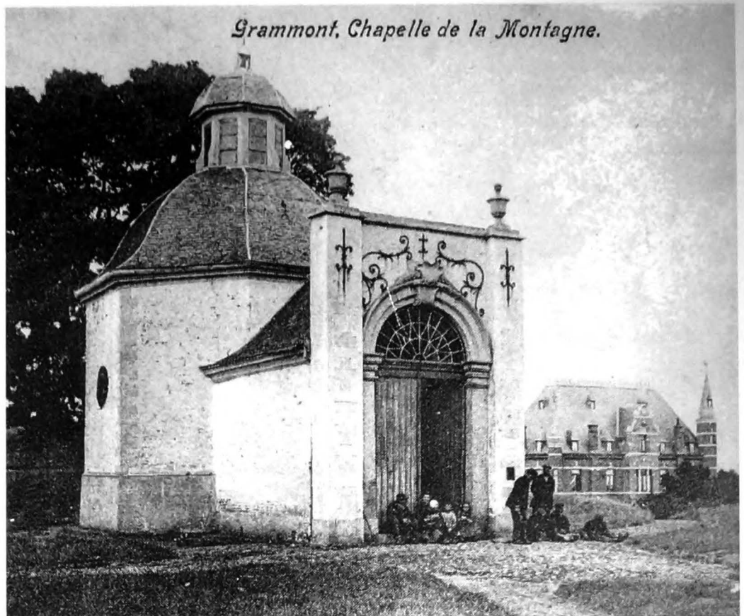
Postkaart met de oude kapel uit 1724 en op de achtergrond het kasteel van notaris De Clercq. De foto is genomen vóór de transformatie van de kapel in juli 1905. Gevel en oostelijke toren van het kasteel zijn intussen al verbouwd.
