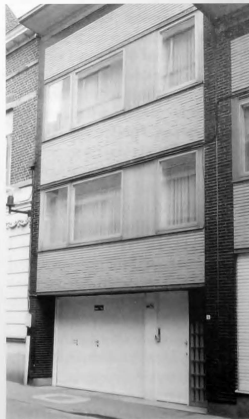
De familie Garcia-Engelen verblijft in dit appartementsgebouw in de Adamstraat 18 van 1963 tot 1969.
