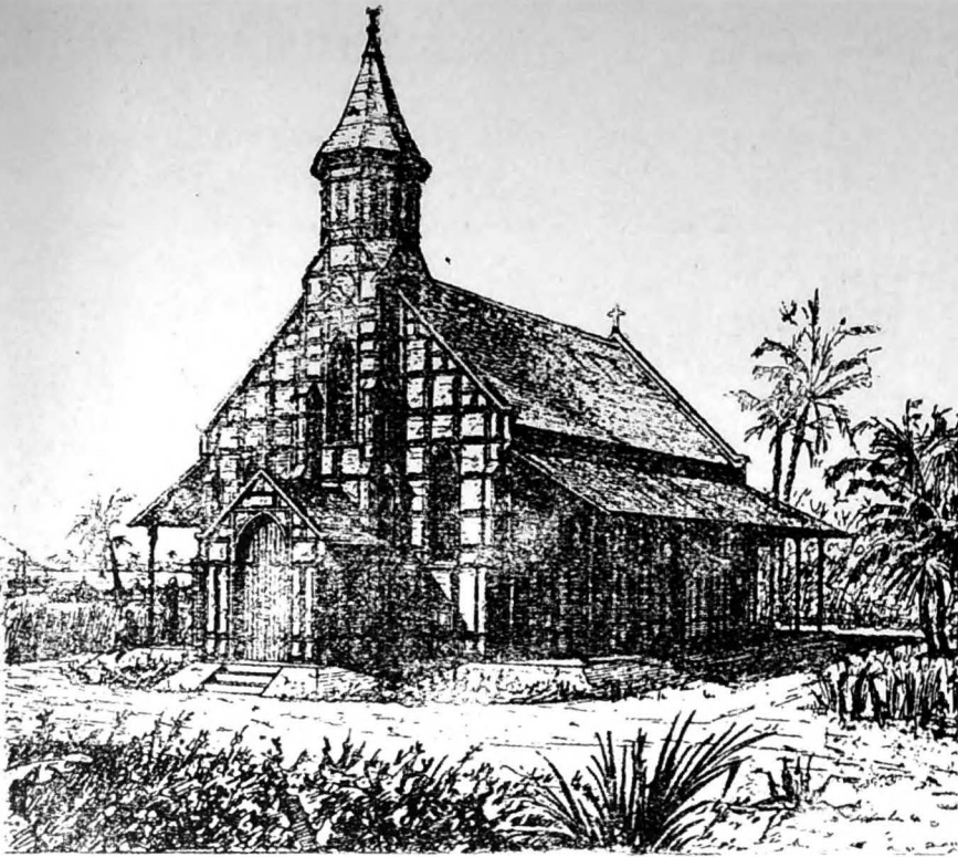
Afb.6: Deze omstreeks 1890 gebouwde kerk in Boma was een stalen constructie, gerealiseerd in de Ateliers d'Aiseau (Henegouwen). Ze was 25 meter lang bij 12 breed. Het gebouw had een dubbele wand wat luchtcirculatie mogelijk maakt en aldus zorgt een zekere mate van klimaatregeling. Hoe vaak zou pater Jules van Trimpont er een mis hebben opgedragen?
