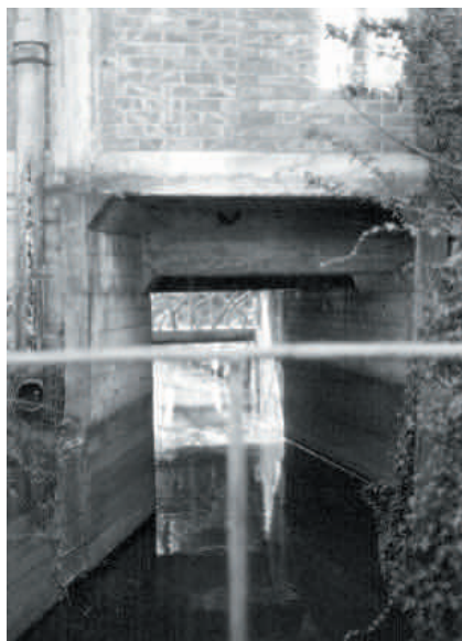
Afb. 27: betonnen overwelling van de Molenbeek (april 2003)
