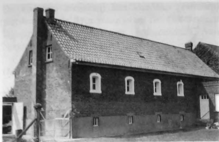
Afb. 1: Kulvestraat nr.1: zicht op de achtergevel van één van de brouwerijgebouwen
